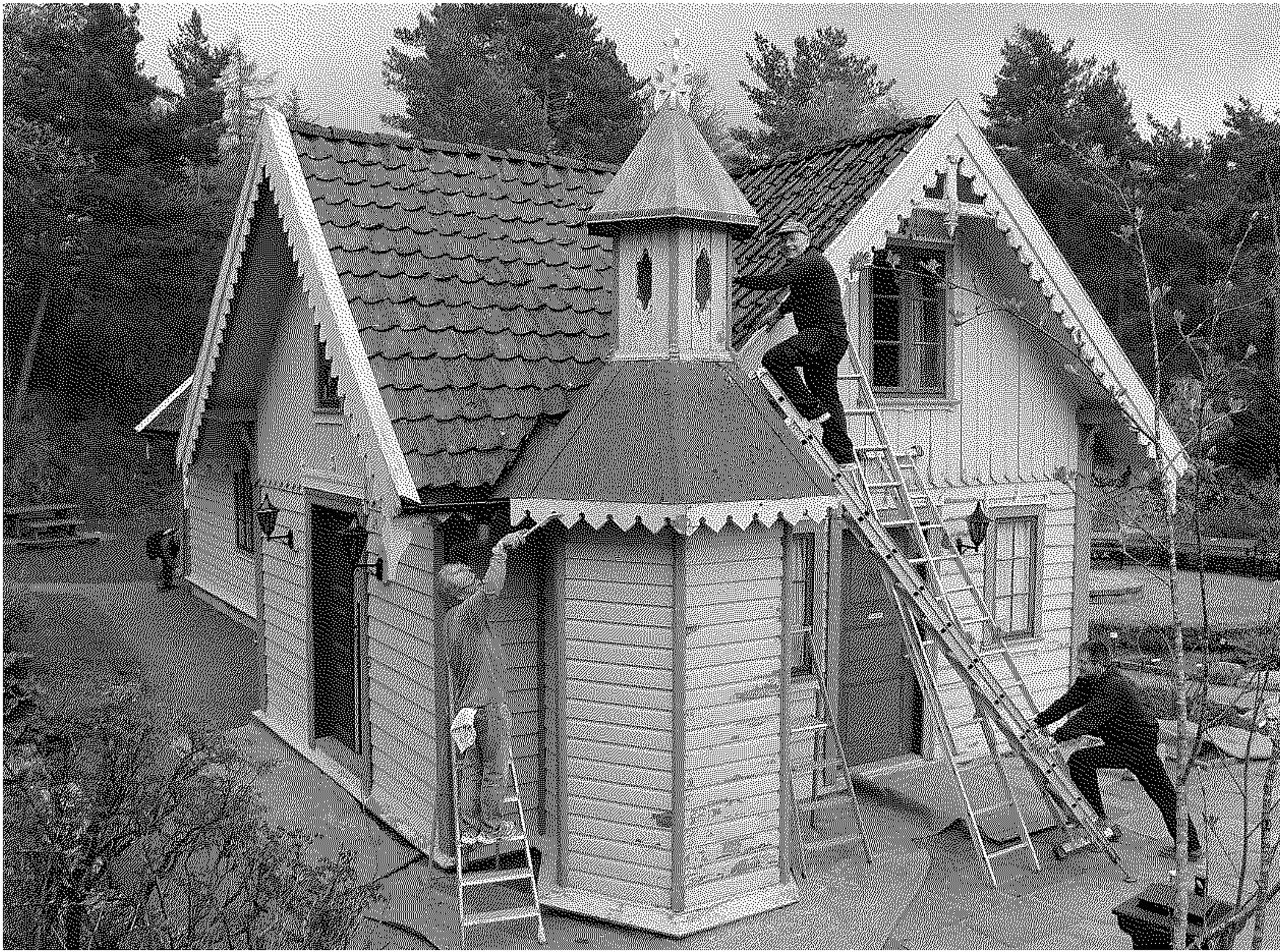
'Blondehuset' ble pusset opp utvendig med assistanse fra "Kor e' Vi", som også skiftet knekte stein på taket (foto: Terhi Pousi, 02.05.2011).
