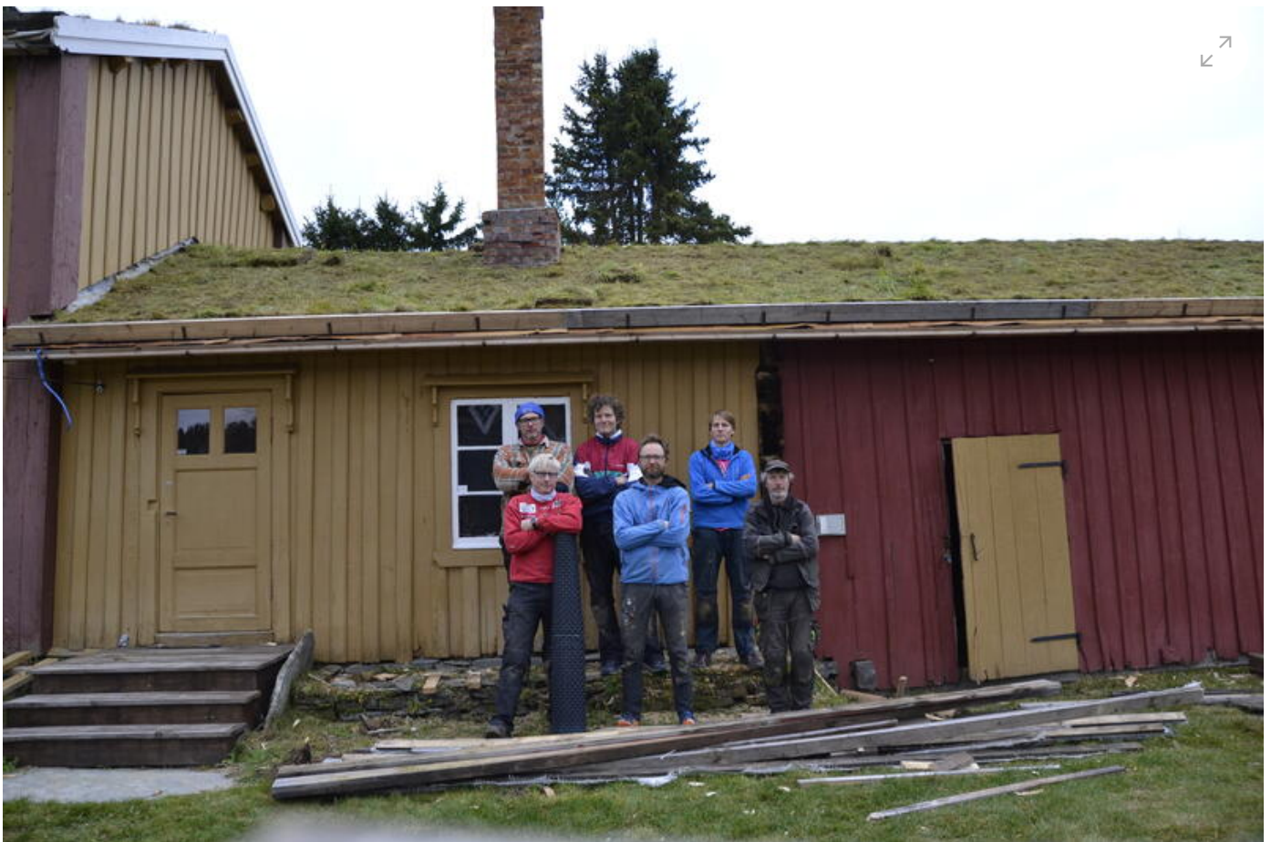
Endelig tak: Torvtaket ble lagt senhøstes på uthuset på Oddentunet. Arbeidsgjengen bestod av bak fra venstre; Bersvend Salbu, Terje Sund, Øystein Gjelten Bakken. Foran fra venstre; Geir Arne Mælan, Audun Lutnæs, arbeidsleder Torgeir Rennemo.
