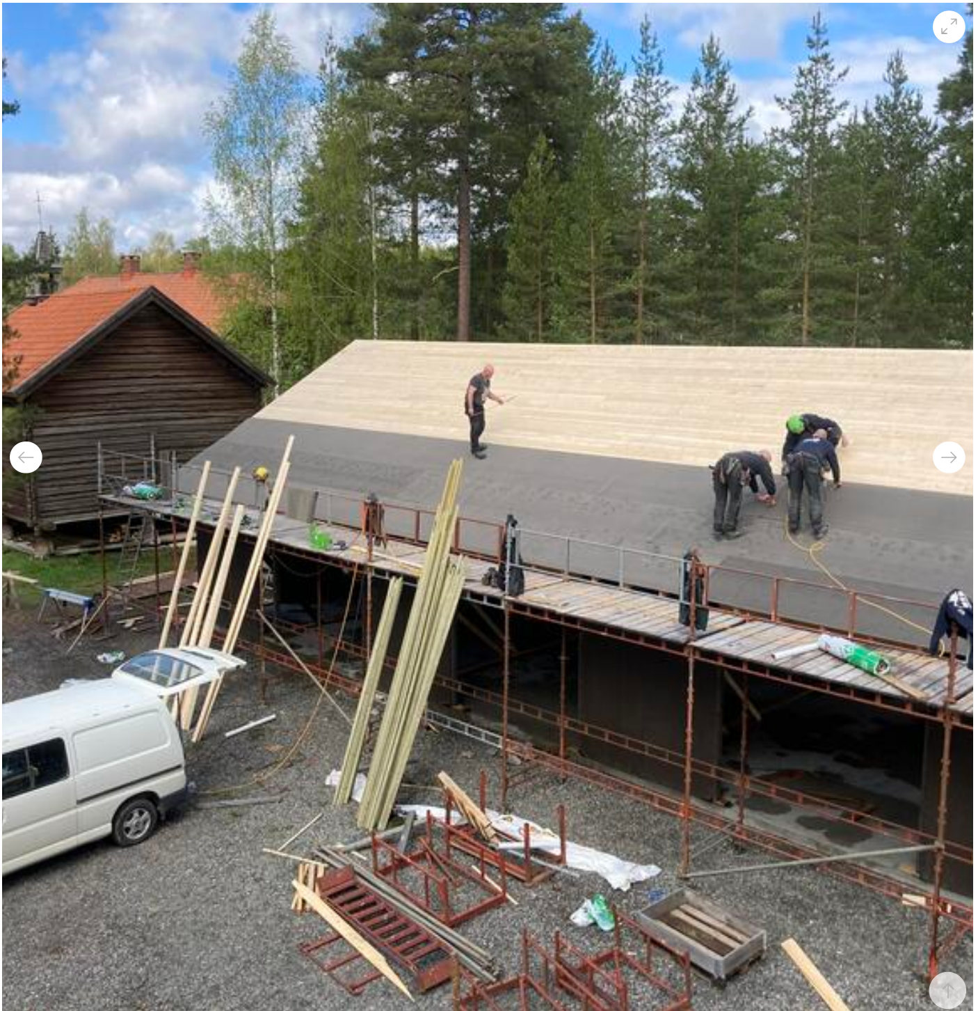
Oppføring av det nye kaldmagasinet på Odalstunet har hatt god framdrift i 2021.
