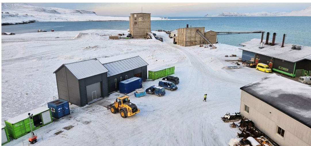
Reservekraftanlegget under oppføring (til venstre i bildet). Tak, vegger, vinduer og porter er på plass. Oktober. Foto: Johannes Lipphardt.
