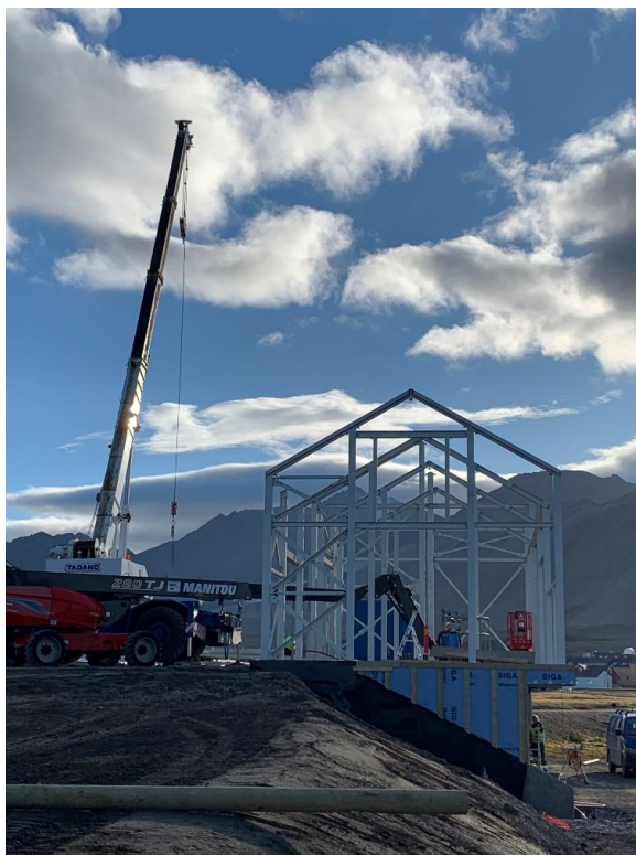
Reservekraftanlegget under oppføring. Reisverket tar form. September. Foto: Aud J Nergård.
