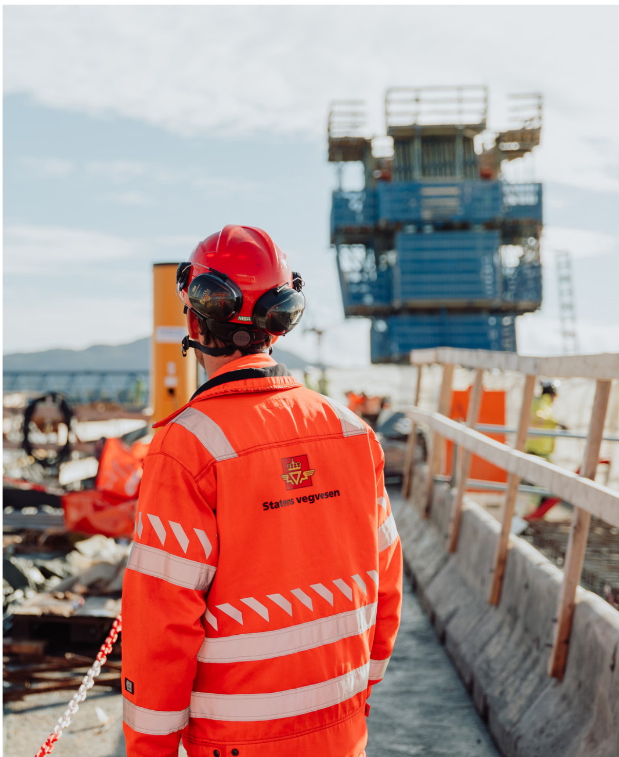
Foto: OPS-selskapet Sotra Link er i gang med bygging av 9,4 kilometer ny riksvei på strekningen fra Kolltveit i Øygarden til Sotravatnet i Bergen. Prosjektet skal åpne for trafikk i 2027. Foto: Karoline Rage, Statens vegvesen.
