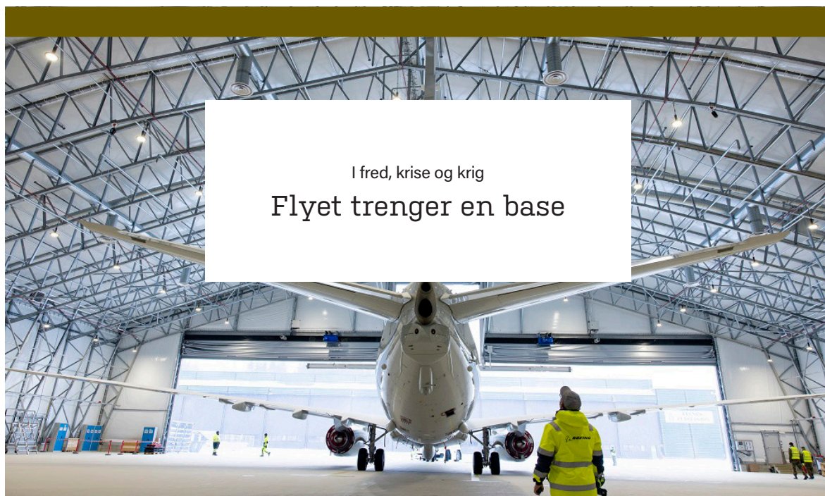
P8 hangar på Evenes flystasjon. FOTO: FORSVARSBYGG
